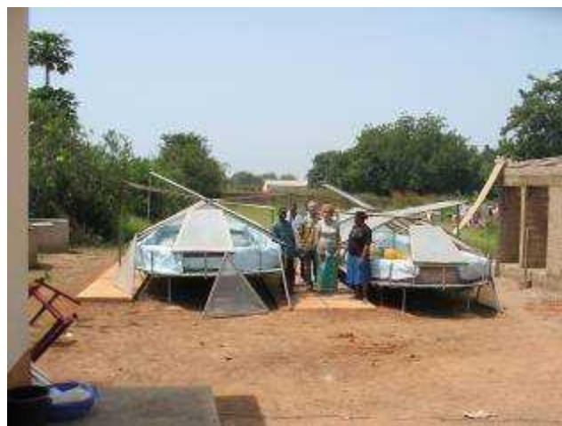
Les 2 bassins en service. A droite, en construction, le bâtiment où se fera le conditionnement.
